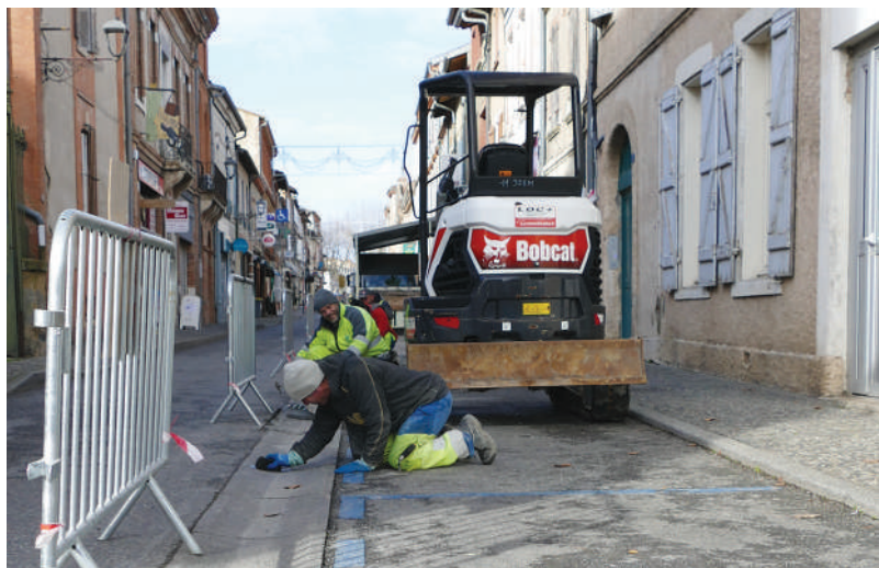
Rue Jean-Jaurès, remplacement des plaques béton abîmées composant le caniveau.
