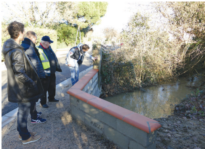
Aménagement au niveau du ruisseau de la Dourdouille : Paul Boué de l'entreprise TP Carbone donne des précisions sur l'installation d'un garde-fou à Guillaume Bourguétou (directeur des services techniques), Rémi Ramond (adjoint au maire chargé des travaux) et Stéphane Peltier de ATEI (maître d'œuvre) lors de la réception du chantier en janvier 2022.
