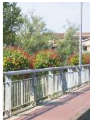
Pont du Jumelage.
