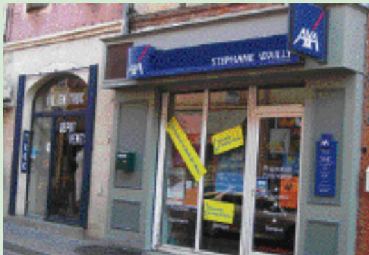
Sur ce rez-de-chaussée l'avancée en béton a été remplacée par une devanture en bois menuisée.
