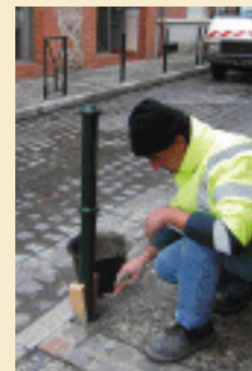
Pose des potelets par nos services techniques.
