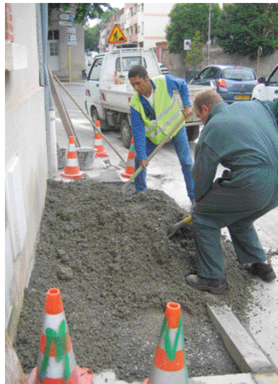
Réfection des trottoirs par les services techniques.
