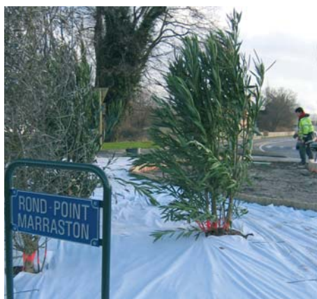
Plantations en cours de réalisation.
