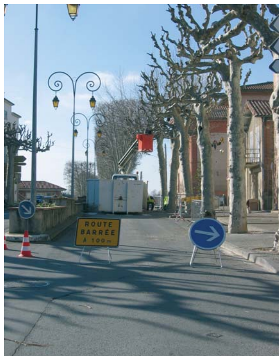
Sécurisation d'une zone de chantier.
