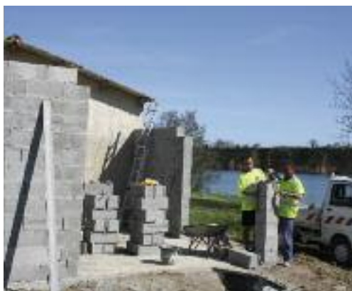
● Construction des sanitaires à la base nautique.
