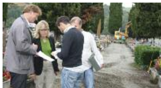
Cimetière 2e tranche, réunion de chantier.
