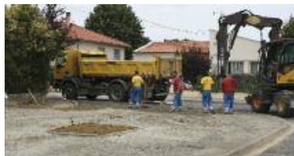
Réfection de la placette Rue Jacques Brel.
