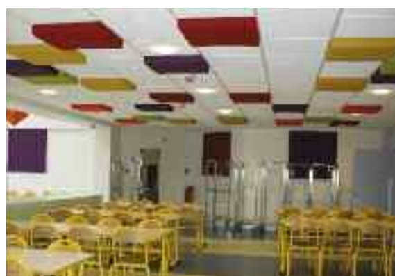
Restaurant scolaire : absorbeurs de bruits.
