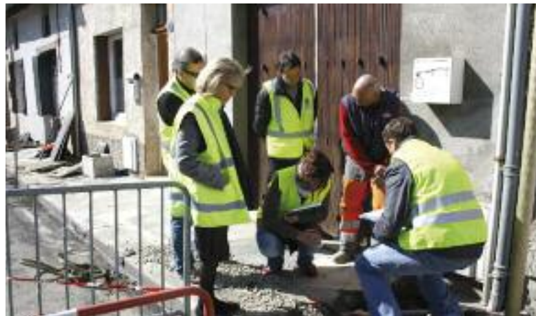
Réunion de chantier avec les différents concessionnaires.
