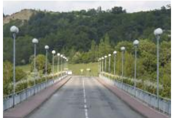
L'éclairage « boules » du pont du Jumelage va être remplacé par des lampes basse consommation moins énergivores.
