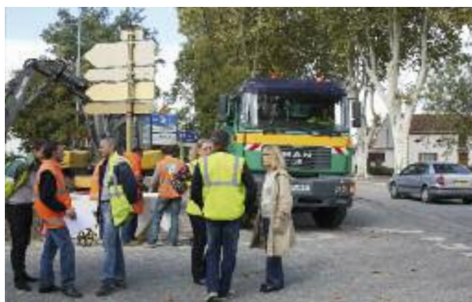
Avenue de Toulouse, réunion de chantier.
