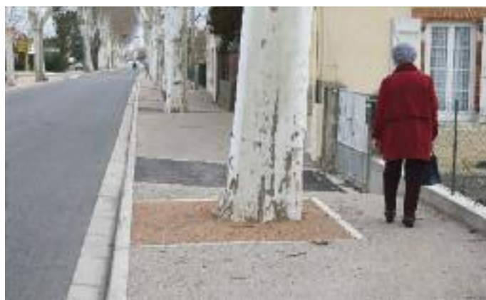
Avenue de Toulouse, réfection du revêtement et des trottoirs.
