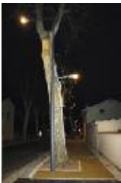
Avenue de Toulouse, l'éclairage faible consommation, nouvellement installé est à double orientation à la fois sur la chaussée et sur le trottoir.
