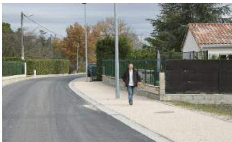
Réalisation des trottoirs et réfection du revêtement, chemin Las Peyrères.
