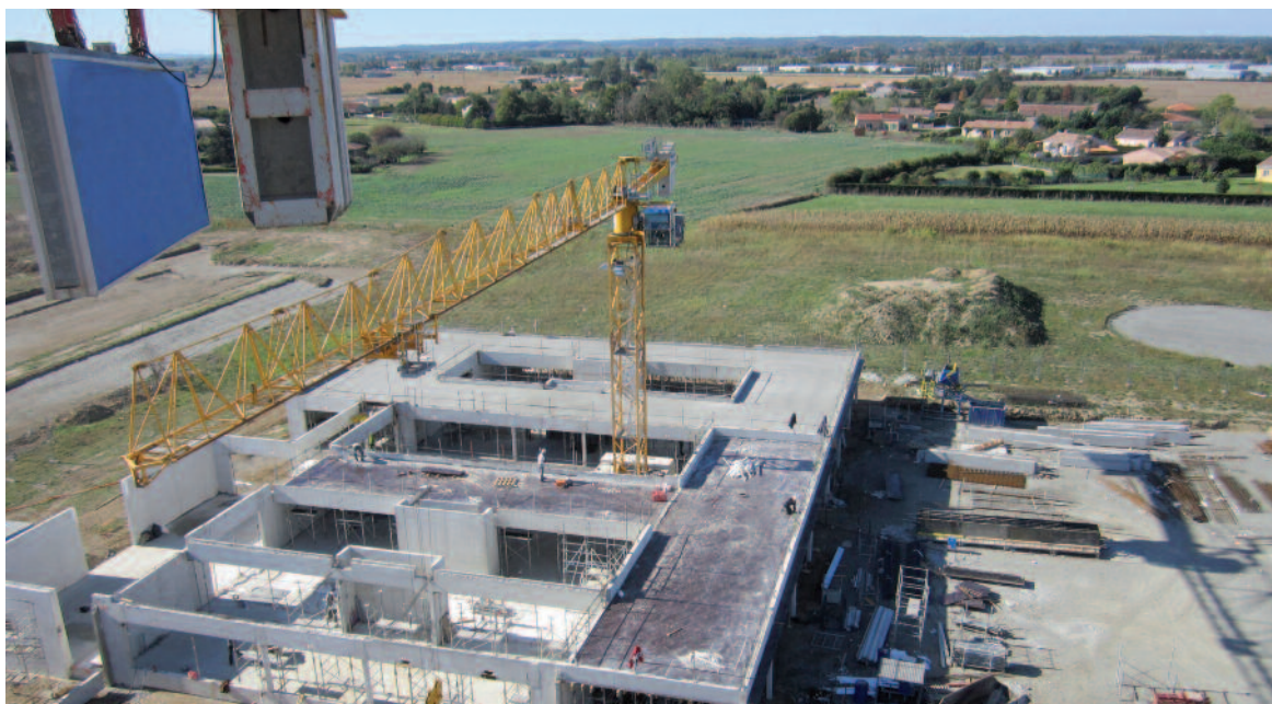
Vue de la grue sur la zone de l'école élémentaire.
