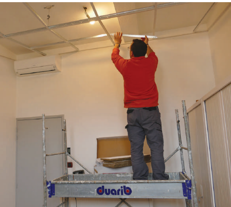
Abaissement des plafonds par le service municipal « Second oeuvre bâtiments ».
