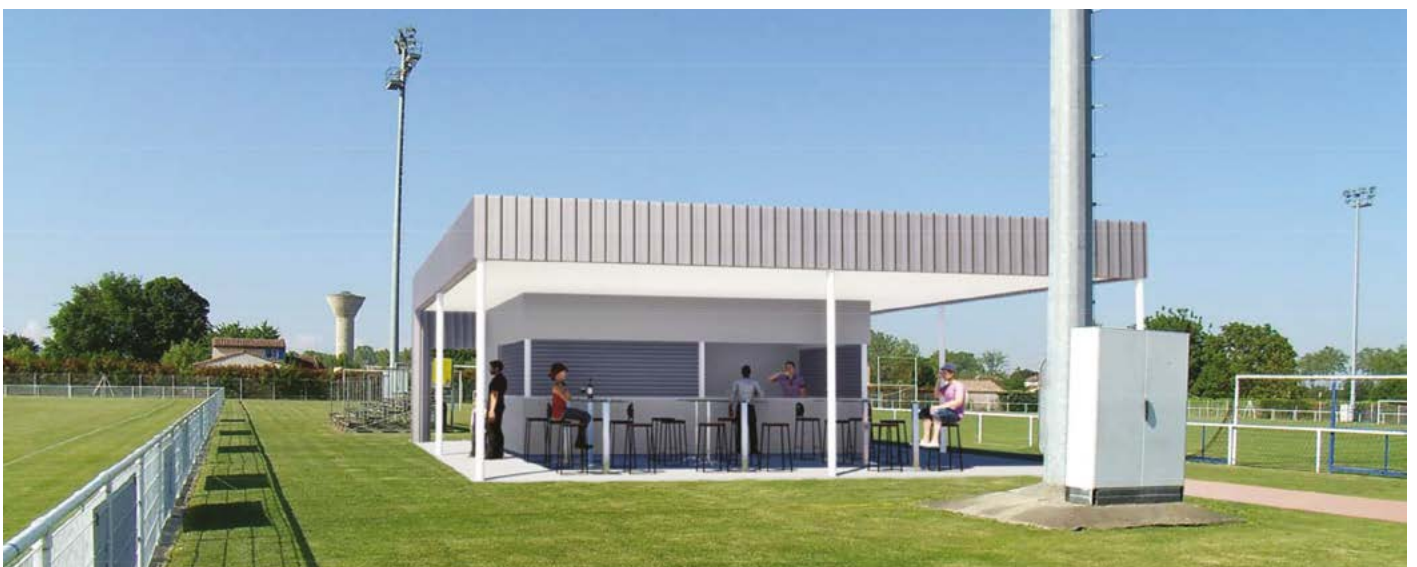
Mise en situation sur le site du futur bâtiment.
