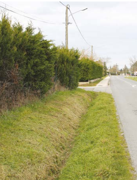
Route de Longages, au fond, piétonnier existant, au premier plan emplacement du prolongement.
