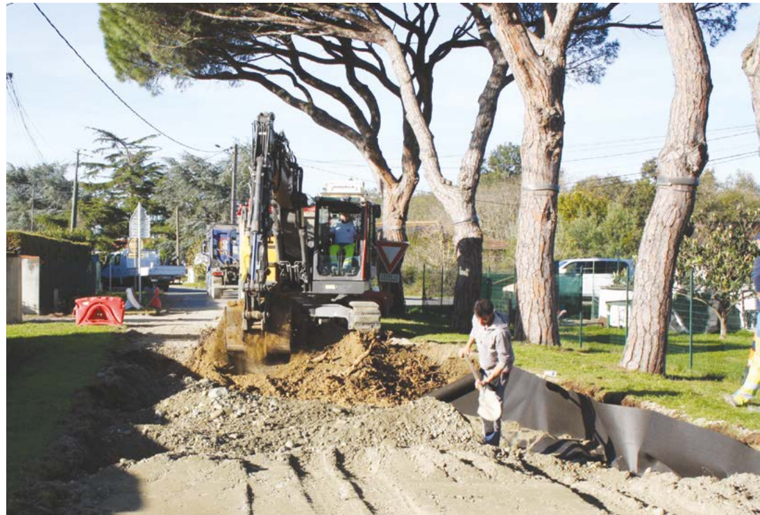
Chemin de Balas, pose du pare-racines.
