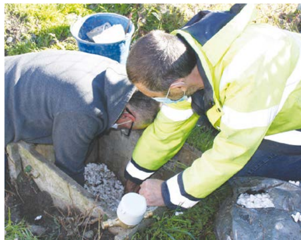
Remplacement d'un compteur d'eau par les agents municipaux.
