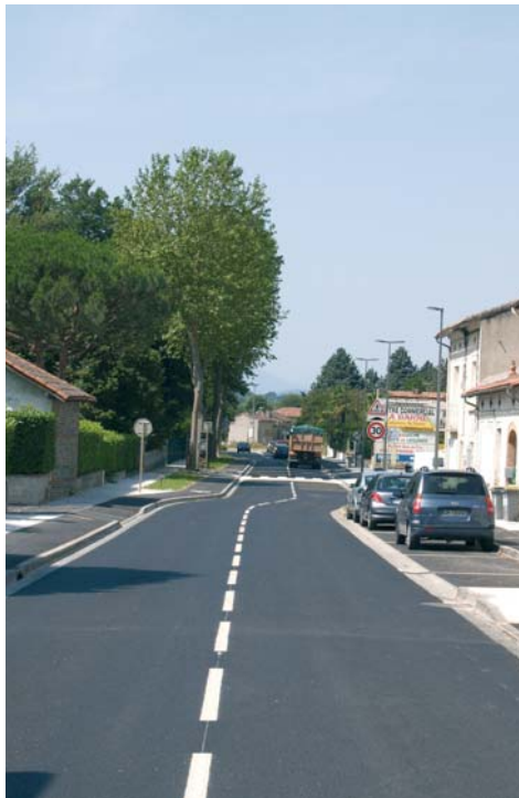
Travaux d'urbanisation terminés.
