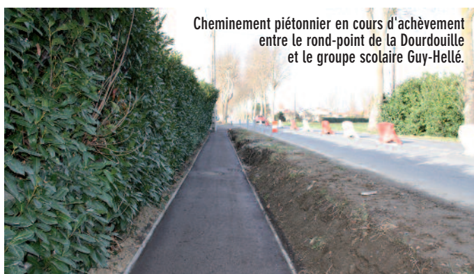
Piétonnier en cours d'achèvement au rond-point du Pradet.
