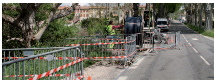
Avenue Frédéric-Mistral, rénovation de la canalisation d'eau potable.
