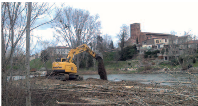
Arrachage d'arbres, abaissement de l'île et enrichissement du lit en galets.
