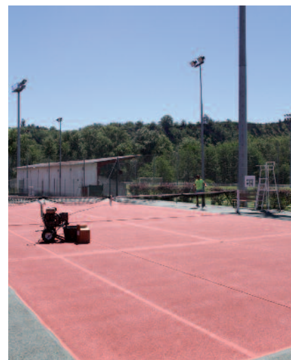
Travaux de peinture du court extérieur.
