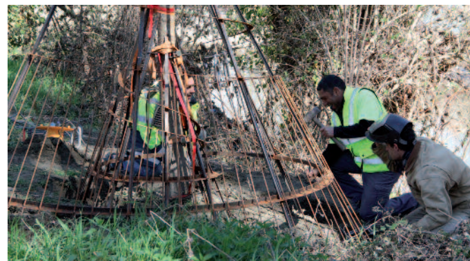
02.2015, Aide à l'installation des Abri(s) par les agents des services techniques.
