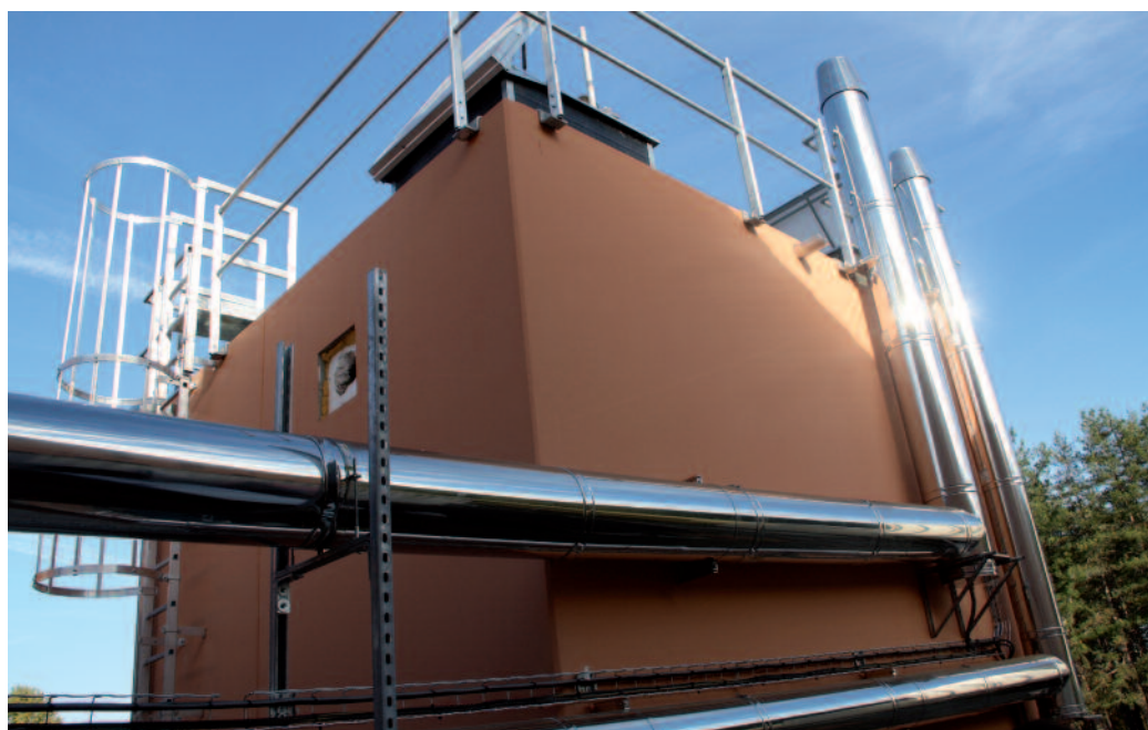
Trémie de remplissage du silo. Capacité : 45 m 3 plaquettes bois ou granulés.
