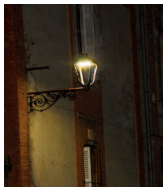
Rue J-Jaurès lampes de style reconditionnées avec une technologie LED.
