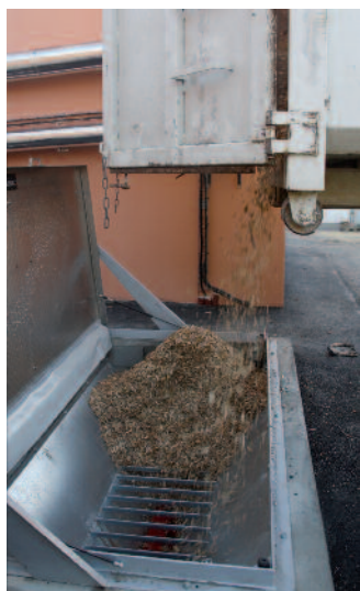
Trémie de remplissage du silo. Capacité : 45 m 3 plaquettes bois ou granulés.
