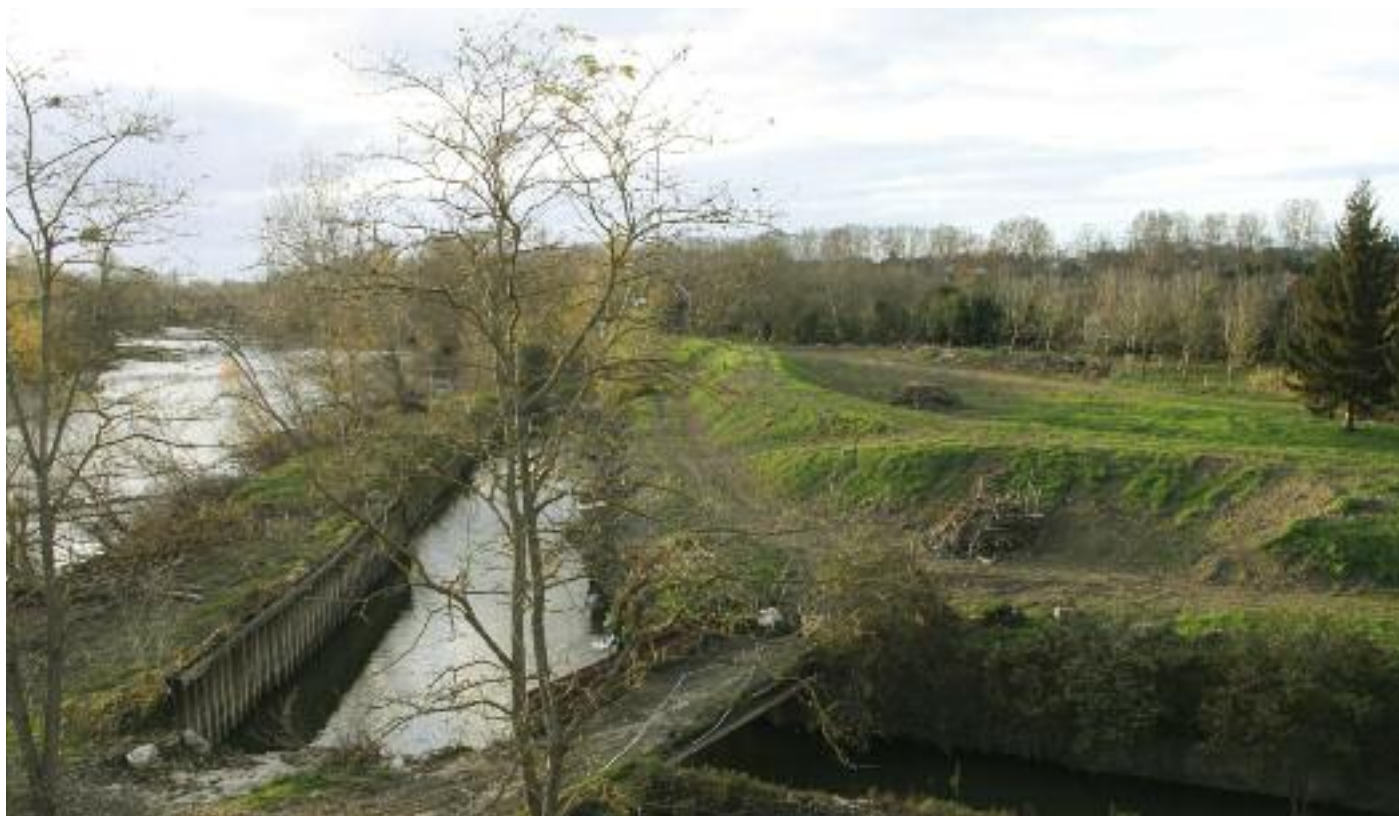
Le ramassage du bois coupé et le nettoyage du site sont en cours et se termineront fin janvier.
