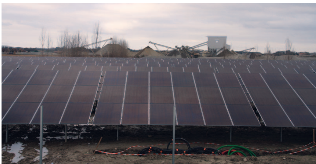
Les structures et les modules sont installés au lieu-dit Bourjaguet.
