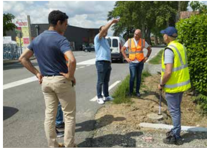
Réunion technique pour la création de la canalisation de la route de l'Arize en présence de Rémi Ramond adjoint au maire en charge des travaux.
