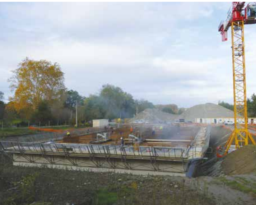
Chantier de la future usine d'eau potable au lieu-dit "Cézeret".
