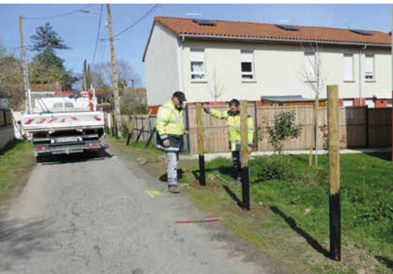
Impasse du Claous, l'installation de potelets bois par le service « environnement espaces verts » permettra d'éviter les stationnements gênants et de préserver la sécurité des piétons.
