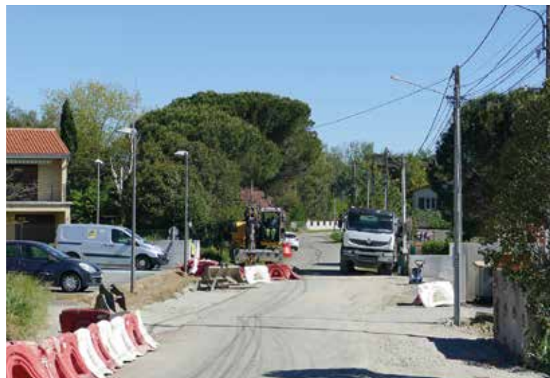
Ces travaux d'urbanisation permettront de réduire la vitesse (zone 30 et circulation alternée), de sécuriser la voie avec un piétonnier et de créer quatre places de stationnement supplémentaires.
