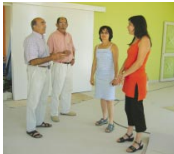
Louis Contréras, Noël Maury (adjoints) ; Brigitte Catala, directrice de la crèche et Sandrine Martin directrice générale des services visitent la crèche en travaux.
