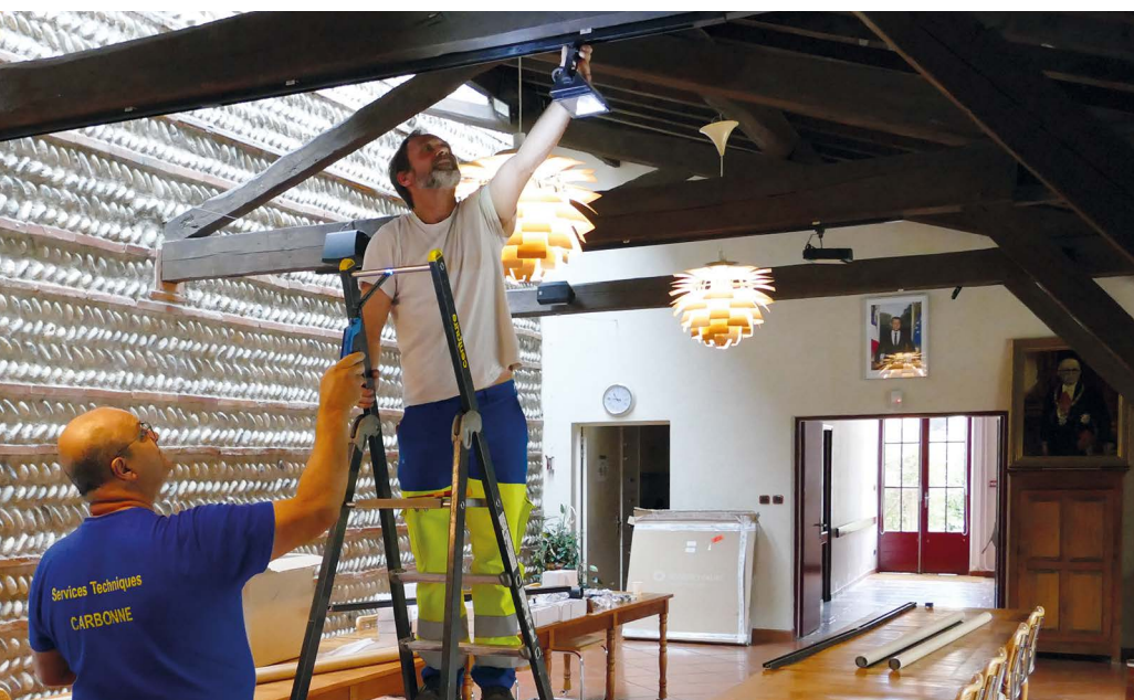
Thierry (de dos) est électricien de formation. Il est épaulé sur ce chantier par Stéphane, notre plombier qui possède également des compétences en électricité.
